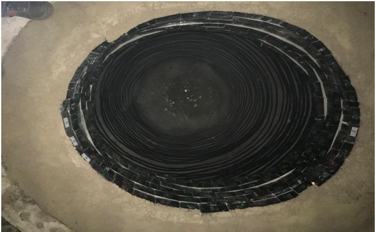
Foto. 7. Murosja complete e murit punues me materiale zjarrdurues
