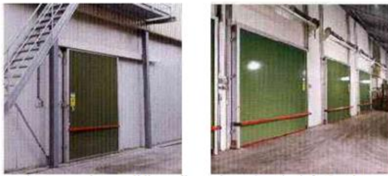
Figura 2.8: Dhoma e ruajtjes në atmosferë të modifikuar dhe të kontrolluar CA [D.S]
