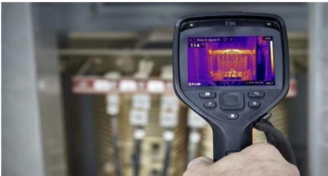
Figura 3.5: Përdorimi i kamerës termike (infra të kuqe) për monitorimin e pajisjeve elektrike.
