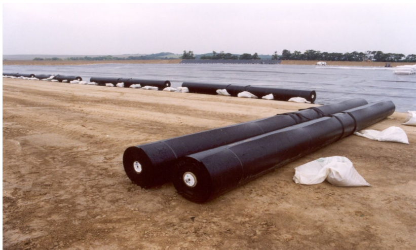
Figura 2.7 Punime gjate mbulimit të dyshemes së deponisë
