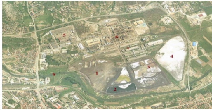
Figura 2. 3: Pamje e deponisë dhe PIM (1-fundërresa; 2-pirit dhe pirotinë; 3-jarosit; 4-fosfogjips; 5-Industria e Baterive; 6-Metalurgjia e Zinkut; 7-Industria Kimike; 8-Lumi Shtënicë)
