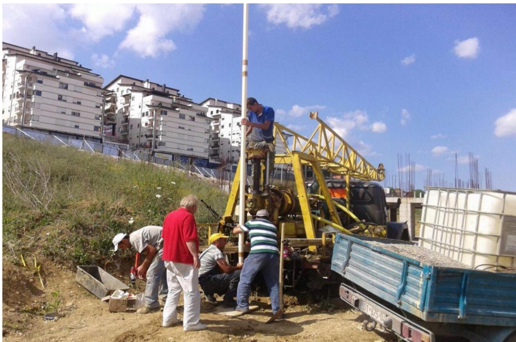
Figura 18. Procedura tipike e instalimit të pjerrtësi matësit (inklinometrit).
