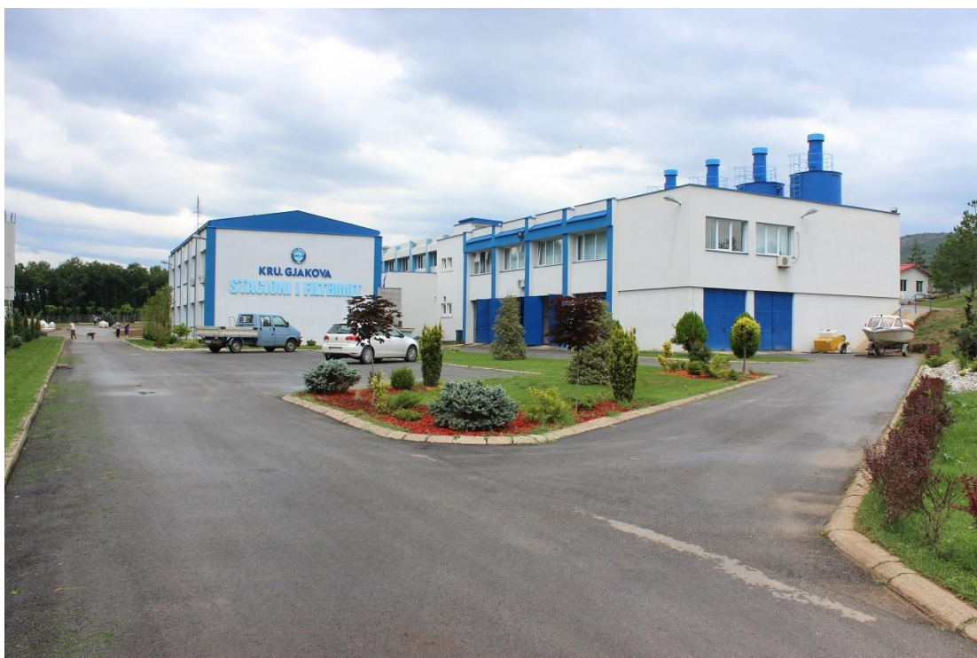
Figura 3.1. Impianti i trajtimit të ujit të pijes në KRU GJAKOVA.
